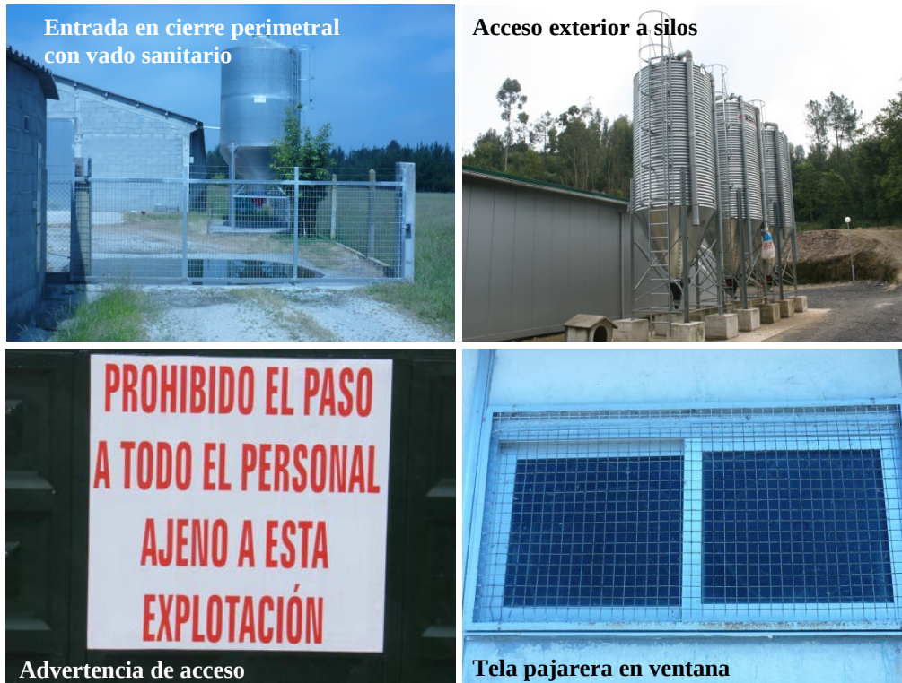
Figura 2. Ejemplos de bioseguridad estructural.
