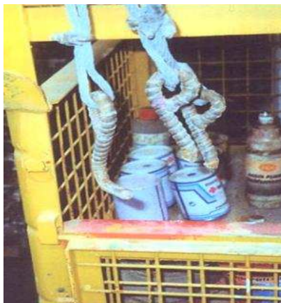
Ejemplo de terminaciones y accesorios no adecuados
