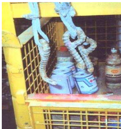
Exemplo de terminacións e accesorios non adecuados
