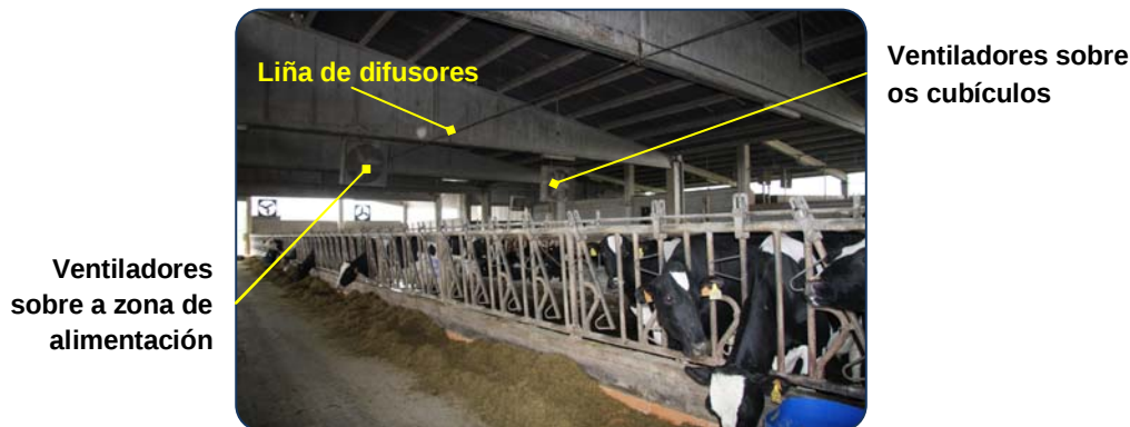
Posición dos ventiladores e dos difusores.
