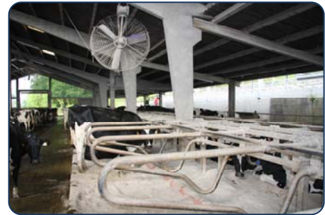
Ventilador sobre cubículos.
