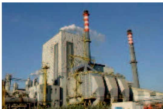
Ilustración 32: Fábrica ENCE en Pontevedra.
