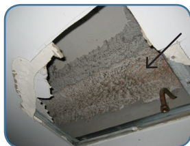
Proxectado sobre viga metálica
