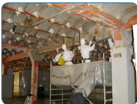
Retirada manual de morteiro de amianto 2
