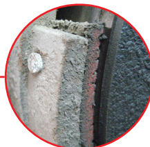
Detalle de zapatas de freo.
