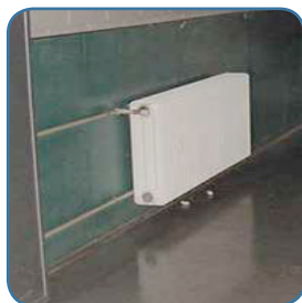
En pavimento e zócalo 1
