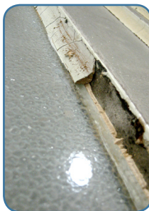
Masilla selante en unión (ventá)
