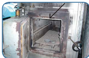
Cordón de amianto que sela a porta 2
