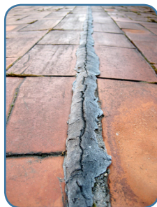
Masilla en xunta de dilatación
