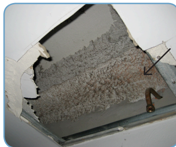
Projectado sobre viga metálica
