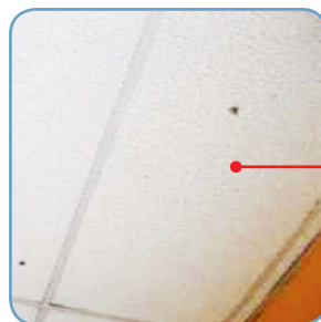
Paneles de falso techo
