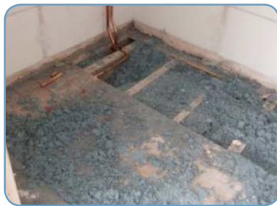
Relleno en el piso (bajo entarimado)
