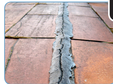
Masilla en junta de dilatación
