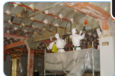
Retirada manual de mortero de amianto 1
