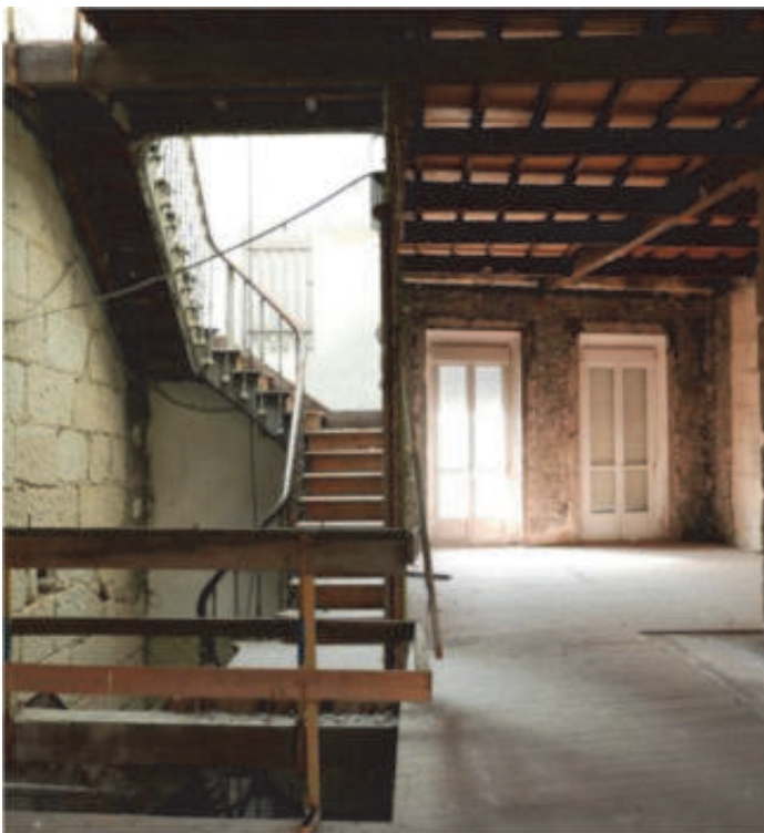
Estructura original de pino tea
