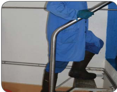
Las escaleras de acceso a la sala deben tener peldaños de material antiresbaladizo y barandas
